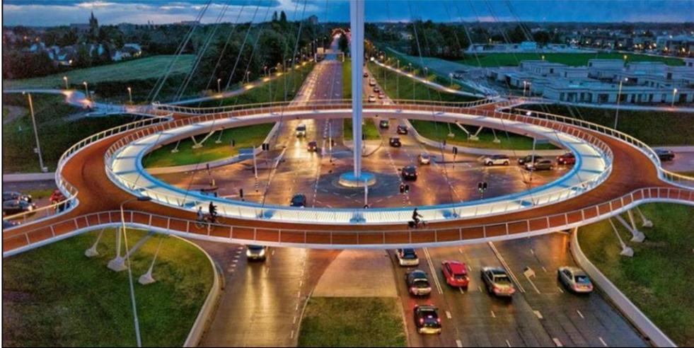
Este es un ejemplo de un cruce para bicicletas con separación a desnivel. El Hovering en Holanda está suspendido sobre un paso a desnivel y separa los distintos medios de transporte. El proyecto se inauguró en junio de 2012. La estructura está suspendida de una torre de 70 metros y parece flotar. Se ha convertido en un importante punto de referencia para Eindhoven, Veldhoven y Meerhoven. Permite que los ciclistas puedan viajar por el cruce sin cualquier conflicto con vehículos.
